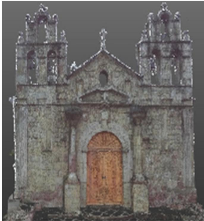
*Nota: Nube de puntos a color de la portada principal de la Iglesia Sicalpa Viejo, levantada con escáner FARO Focus Láser 3D y depurada con programa software Trimble Real Works.*
