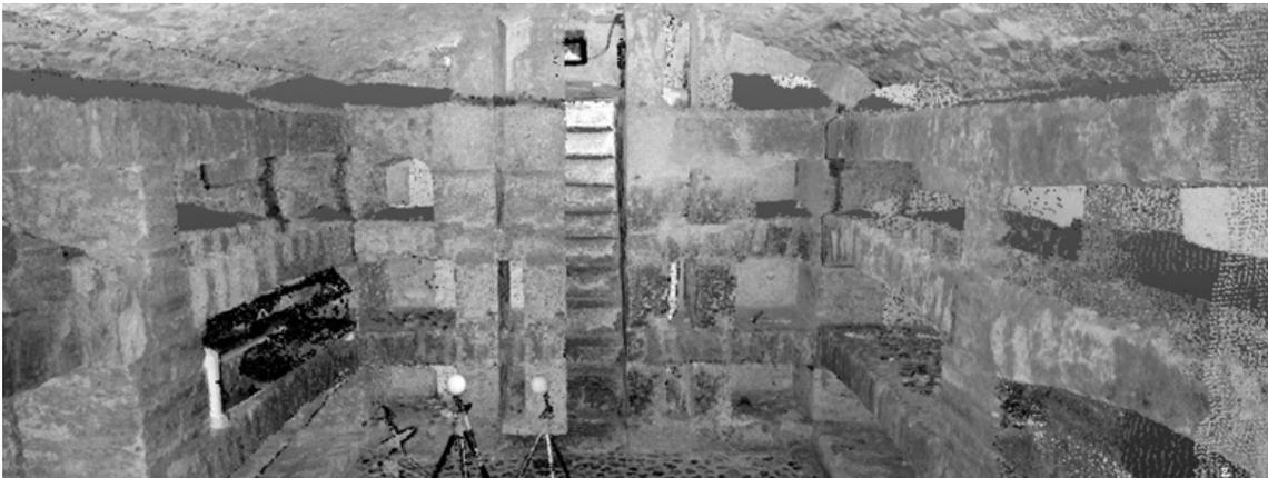
*Nota: Nube de puntos de las catacumbas de la Iglesia Nuestra Señora de las Nieves de Sicalpa Viejo, levantada con escáner FARO Focus Láser 3D y depurada con programa software Trimble Real Works.*
